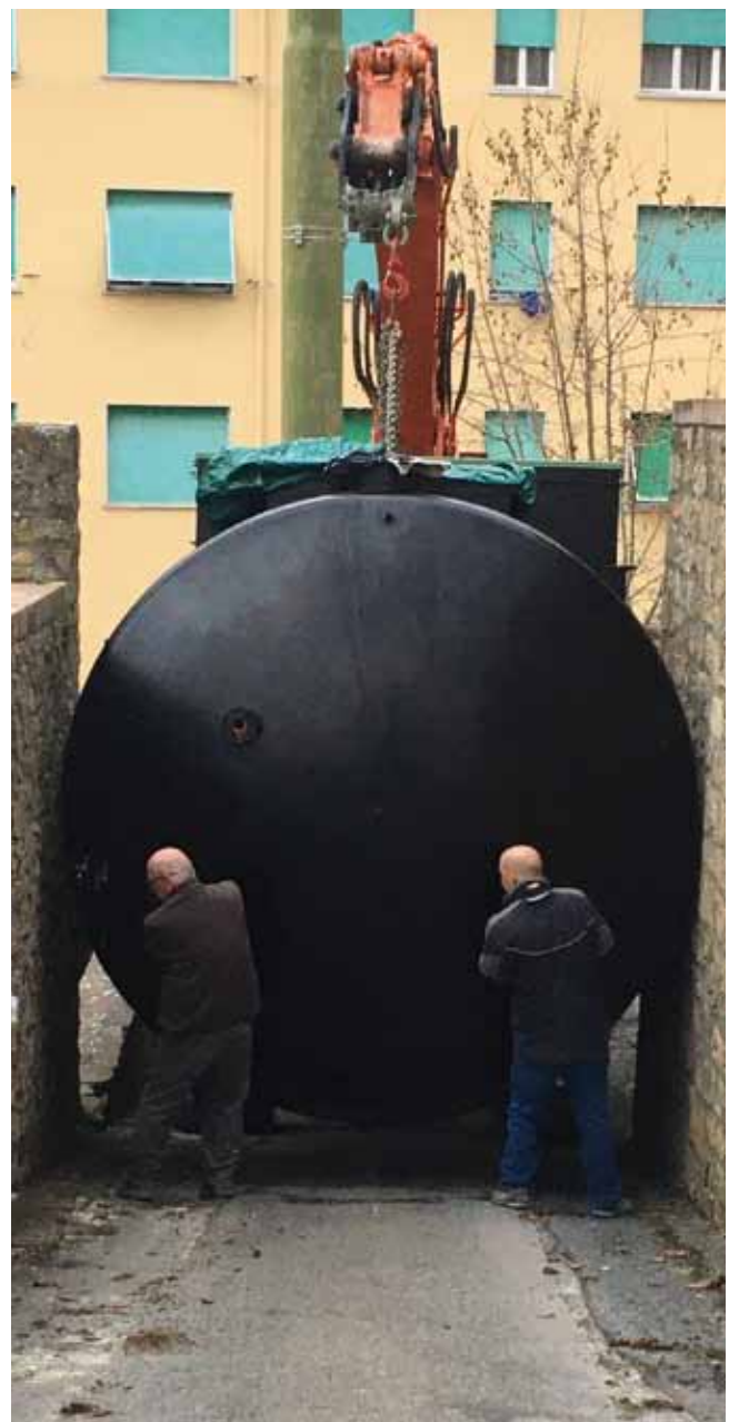
Lavori di adeguamento
